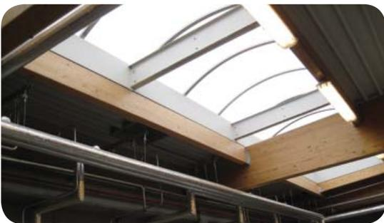
La priorité à l'éclairage naturel est assurée par de larges lanterneaux et des circuits électriques multiples qui permettent de ne pas utiliser les luminaires là où ils ne sont pas nécessaires (pas d'activité ou d'occupation) et d'utiliser uniquement l'éclairage naturel si celui-ci est suffisant.
