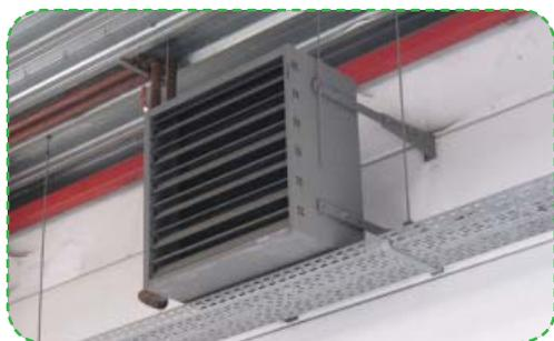
Il faut veiller à ce que les aérothermes soient **PLACES A BONNE HAUTEUR** (idéalement à 1 m en dessous du plafond) afin qu'ils puissent pulser l'air chaud stratifié vers le bas.
