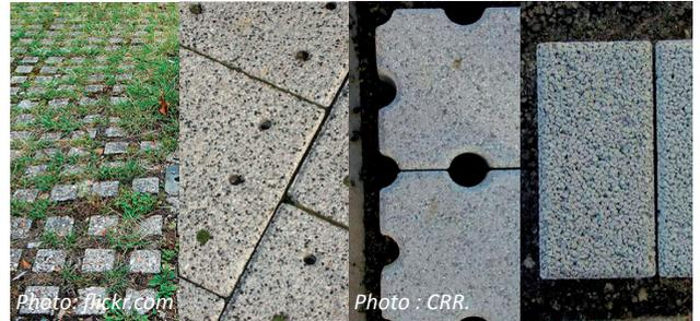
Pavement perméable à larges joints, percés, en béton poreux.
