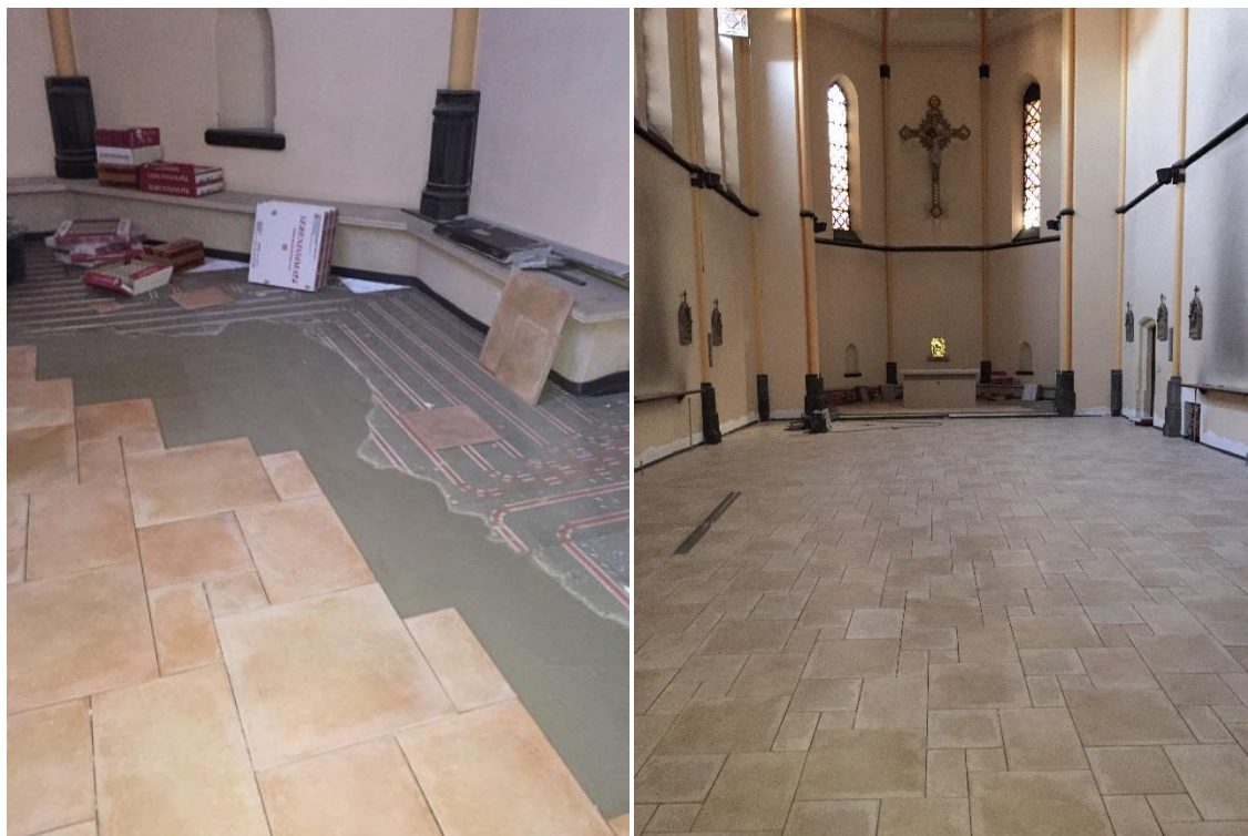
8: Phase 5 : Placement d'une finition
