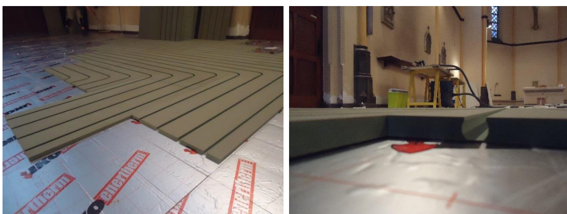
6 : Phase 3 : Placement de la structure préfabriquée accueillant les tuyaux de chauffage sol
