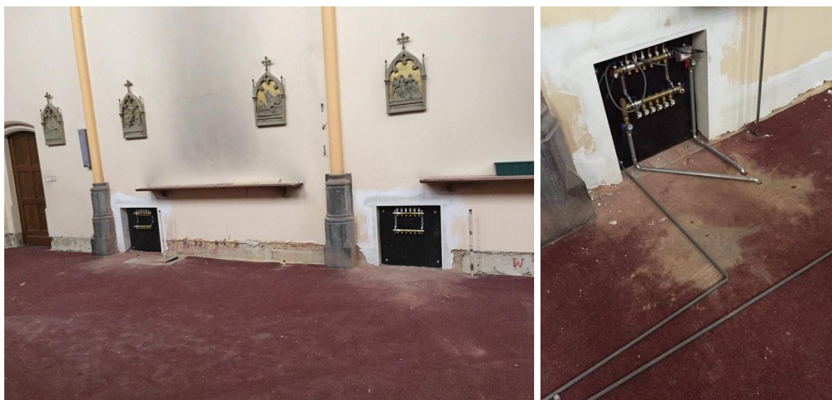
4: Phase 1 : Préparation du support et des circuits de chauffage
