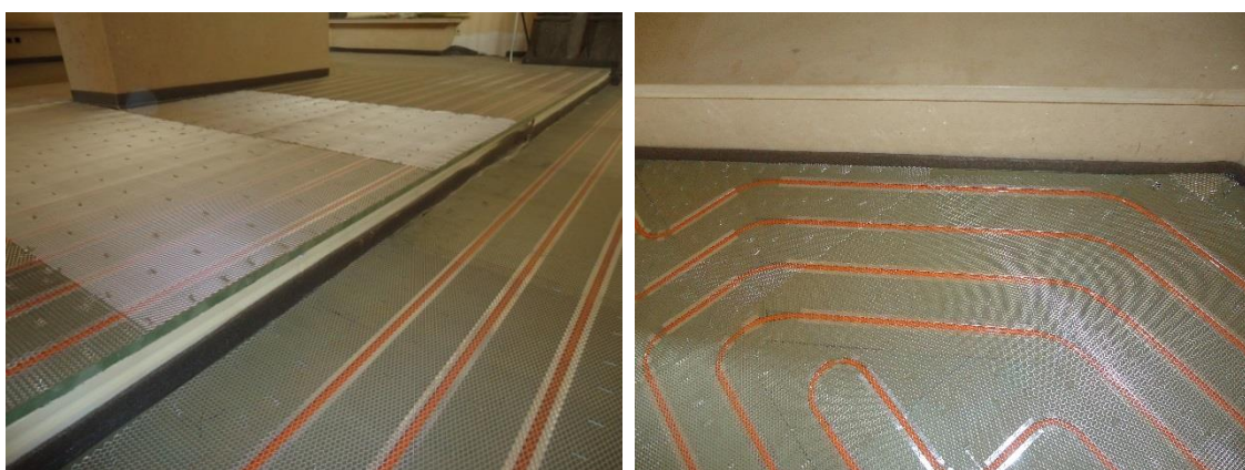
7 : Phase 4 : Placement des tuyaux et du grillage
