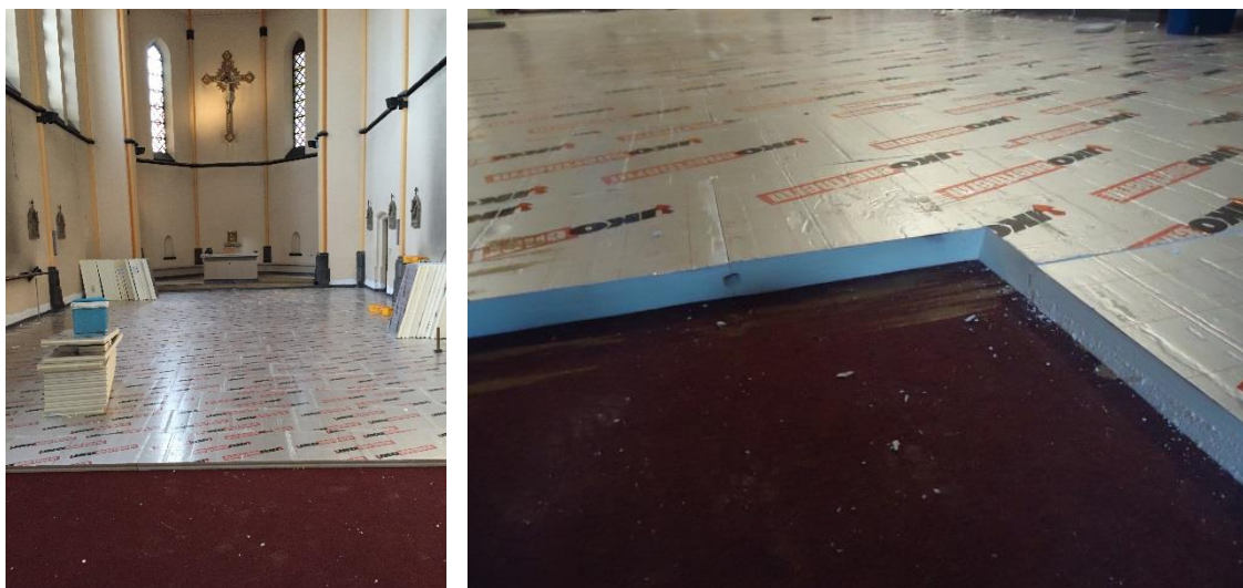
5 : Phase 2 : Placement d'un isolant sur l'ancien niveau fini
