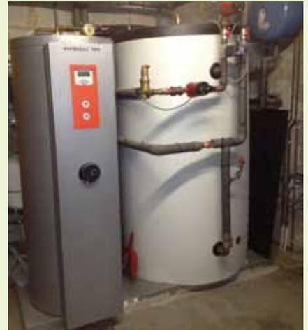
La chaudière à pellets alimente un volumineux ballon d'eau chaude de chauffage (à dr.) ce qui lui évite des redémarrages fréquents. Le ballon d'eau chaude sanitaire s'y alimente en chaleur en période de chauffe si les panneaux solaires ne suffisent pas.
