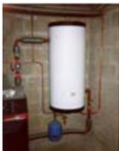
La dilatation de l'eau en chauffe dans le boiler peut produire une pression trop importante et créer cette fuite d'eau chaude via la soupape de sûreté. Placer un seau sous le groupe de sécurité afin d'estimer la fuite. Le danger est que la soupape s'encrasse de calcaire et perde par goutte à goutte. On estime la perte annuelle à quelques m<sup>3</sup>/100 litres de stockage.
