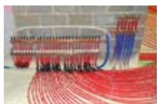
L'eau de chauffage introduite dans le rayonnement est à basse température et le fait que la surface d'échange (toute la surface du sol) soit énorme permet
