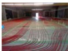
Son bon fonctionnement nécessite que le bâtiment soit bien isolé (sol sous les tubes du rayonnement, en particulier).
