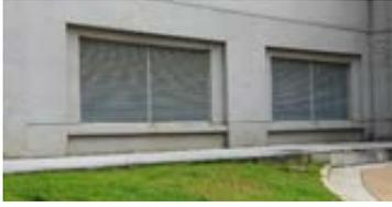
Il s'agit de ventiler passivement le bâtiment en y introduisant de l'air frais afin de refroidir la masse du bâtiment. La ventilation se fait naturellement par ouvertures de baies dans les façades et la toiture éventuellement.
