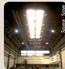
Magasins de stockage chez ArcelorMittal (nouveaux bâtiments) : 3 halls de 80 x 18 m<sup>2</sup> et de 16 m de hauteur : 112 radiants à gaz lumineux de 27 kW répartis en 9 zones et disposés à 13 mètres de hauteur au-dessus des ponts-roulants.
