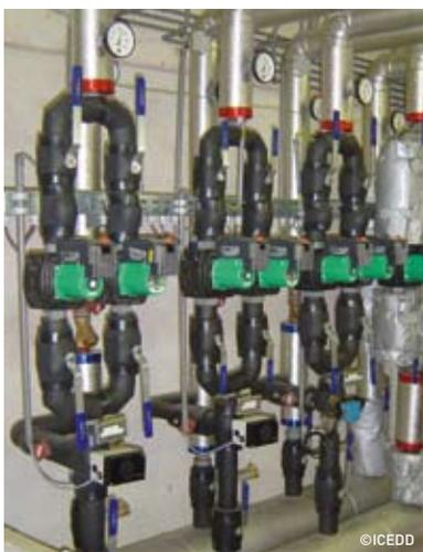
*Bonne isolation des conduites et des vannes d'une chaufferie à la suite d'une rénovation au CHR de Mouscron*
