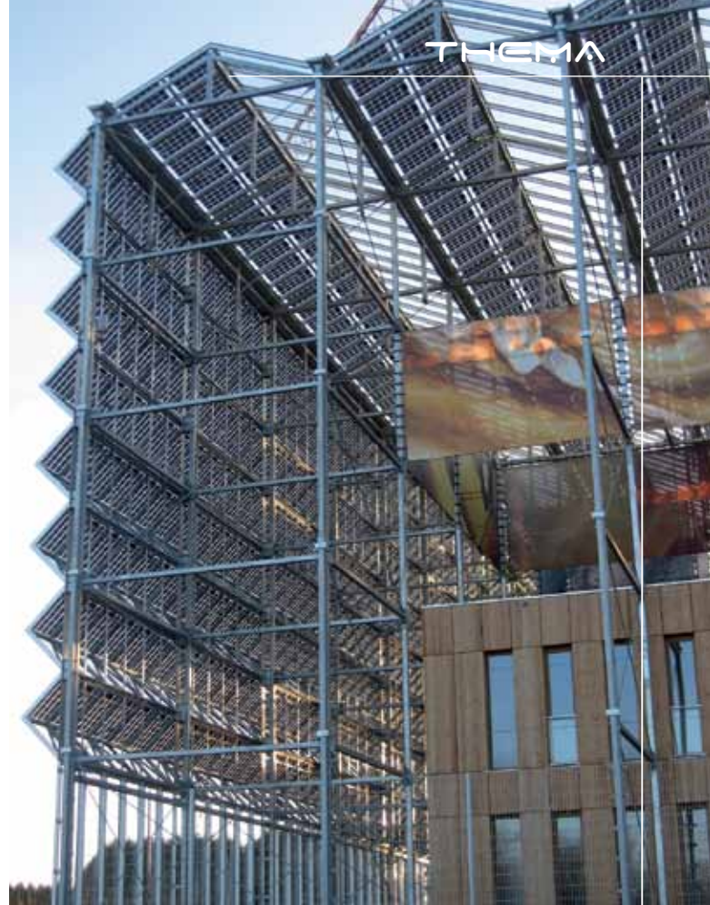
Au centre Galaxia (Barrière de Transinne) l'électricité est produite par des panneaux photovoltaïques sur une superficie de plus de 2 000 m 2 .
