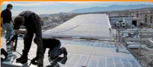
ISSOL. Large de 14 m et s'étalant sur une longueur d'environ 200 m, ce toit photovoltaïque prend la forme d'un ensemble de vagues translucides destiné à alimenter l'édifice en électricité. Composée de cellules de silicium de type monocristallin à haut rendement (17,5 %), la structure fait à la fois fonction de toit de protection, de pare-soleil et d'unité productrice d'énergie.
