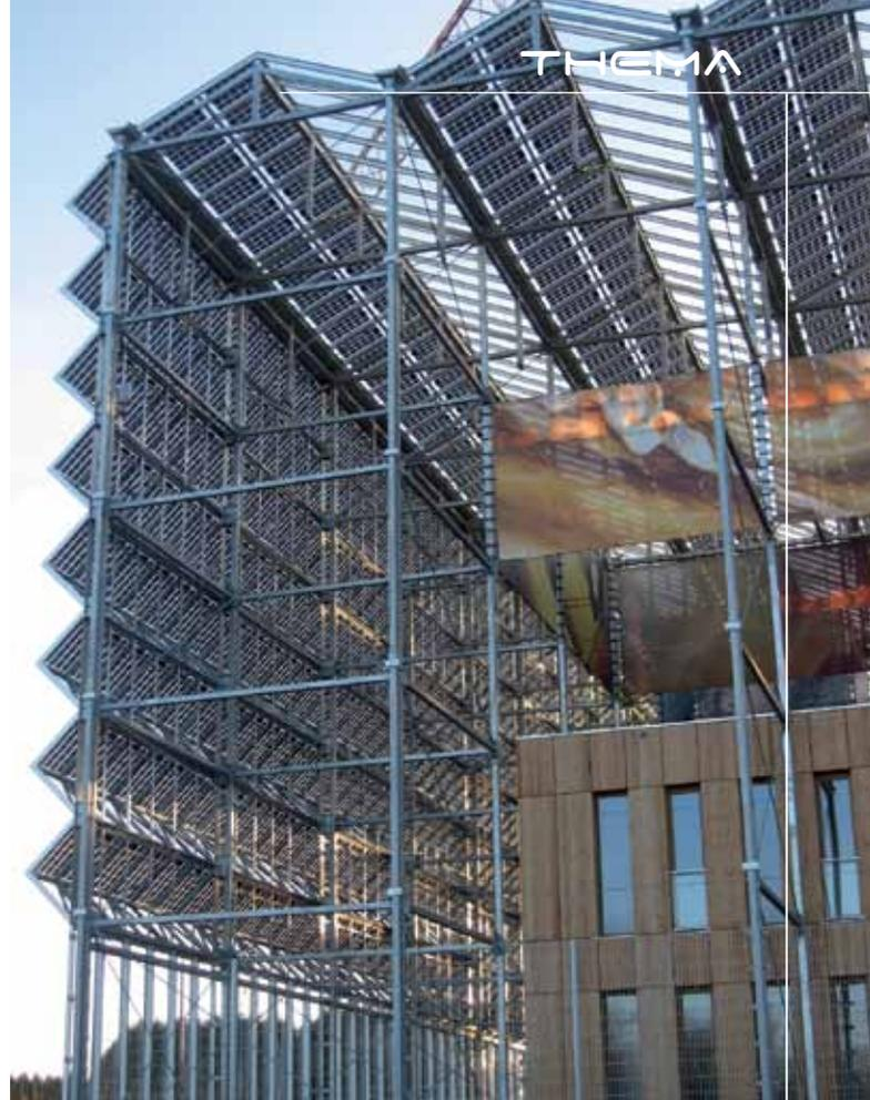
Au centre Galaxia (Barrière de Transinne) l'électricité est produite par des panneaux photovoltaïques sur une superficie de plus de 2 000 m<sup>2</sup>.
