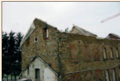
La décision doit être prise et l'installation dimensionnée avant l'arrivée du couvreur...
