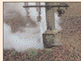
Vapeur de revaporisation en sortie d'un purgeur
