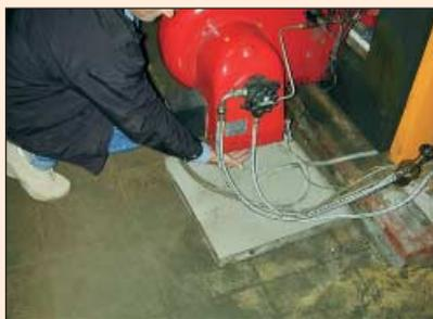
Un simple geste permet de se rendre compte que le clapet d'aspiration d'air du brûleur reste ouvert à l'arrêt, entraînant un courant d'air important dans la chaudière, et l'évacuation de sa chaleur vers la cheminée coup d'œil sur le rendement indiqué au bas de l'attestation d'entretien que lui remet le chauffagiste?.
