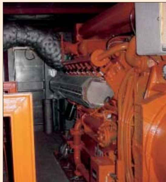
Module decogénération 832 kW e et ballon de stockage 100 m 3 au CHR de Namur. Propriétaire: Electrabel. Gestionnaire: Axima Services.
