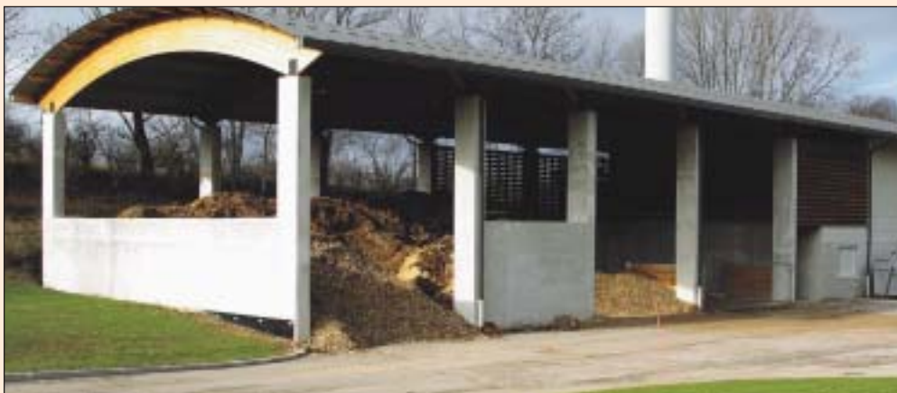
Le hangar de stockage, le silo et la chaufferie de Hauteville (Ain – Fr) Ce projet alimente plus de 20 bâtiments pour une puissance installée totale de plus de 6,8 MWth, dont 3,2 MW bois, 1,5 MW issus de la turbine à gaz (co-génération) et 2,1 MW en appoint gaz.
