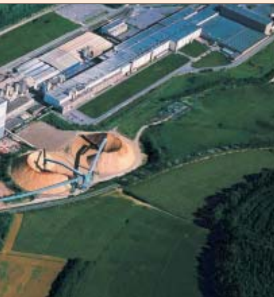
On voit la construction d'une deuxième ligne de production de papier et dont la consommation spécifique sera encore inférieure à la première.
