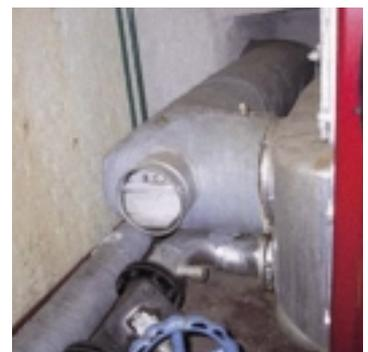
Au-dessus de 10 et 15 Pa, la présence et le réglage d'un régulateur de tirage sur la cheminée s'impose.
