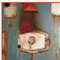
La rouille observée sur les carrosseries des vieilles chaudières est le signe d'inétanchéité.
