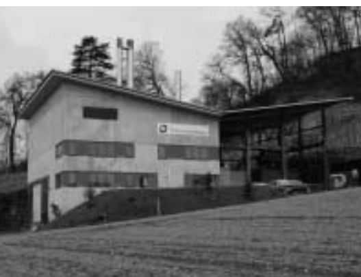
La chaufferie unique de Thermoréseau à Porrentruy; en lieu et place de 65 chaufferies individuelles
