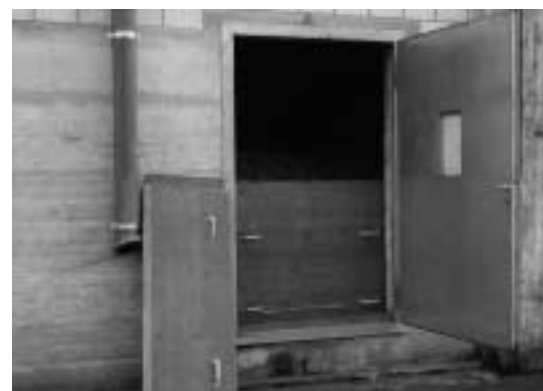
Silo aérien: porte de visite et tuyau de remplissage.
