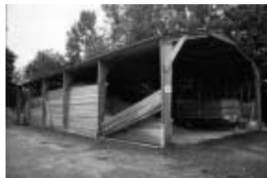
Hangar de stockage
