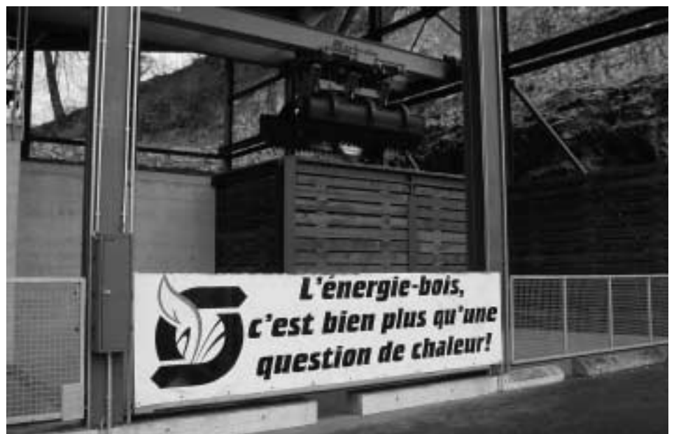
Un slogan qui en dit long! (Thermoréseau à Porrentruy - CH)
