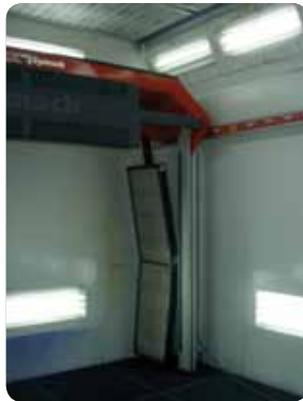
Toutefois la problématique de la ventilation dans les cabines de peinture restait entière : lors de la phase de mise en peinture, la température doit généralement être comprise entre 22 et 25 °C et la ventilation doit se faire à 0.4 m/s. En moyenne le débit de la ventilation est de l'ordre de 30 000 m<sup>3</sup>/h. On évalue alors la consommation énergétique d'une cabine dans cette phase à 140 000 kWh/an.
