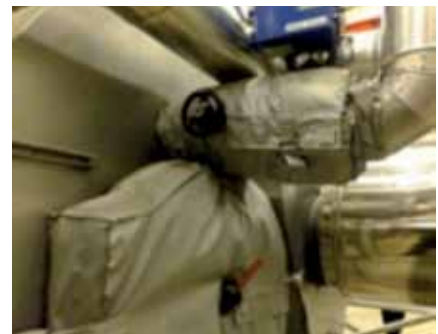
Isolation d'une porte d'ouverture de maintenance d'une chaudière vapeur
