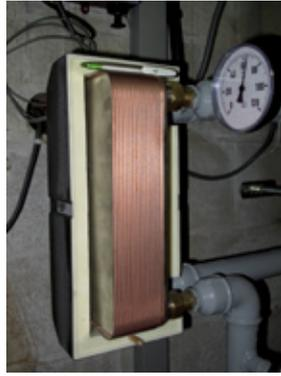
Échangeur thermique (60 kW)
