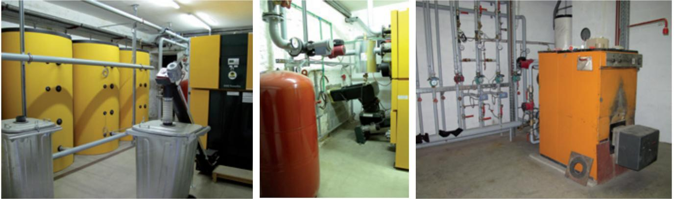
La chaufferie centralisée, les ballons accumulateurs et l'amenée du combustible à la chaudière. La chaudière backup au mazout. Les illustrations montrent que toute l'installation doit encore être calorifugée.
