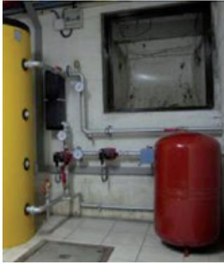
Sous-station avec ballon accumulateur (800 litres)
