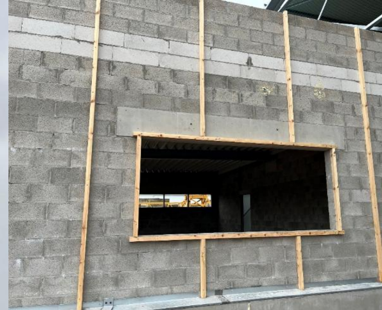
3) Bloc Ytong – intercalaire isolant entre l'isolant de toiture et l'isolation de façade
