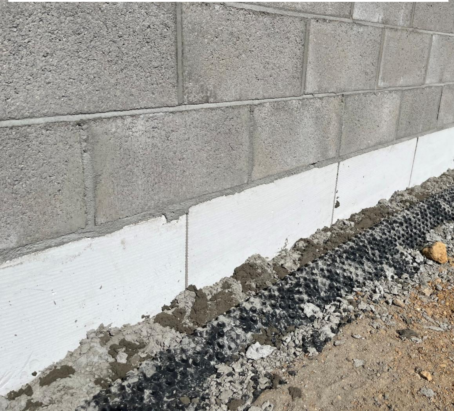
1) Bloc Ytong pour intercalaire isolant au pied de mur en bloc béton
