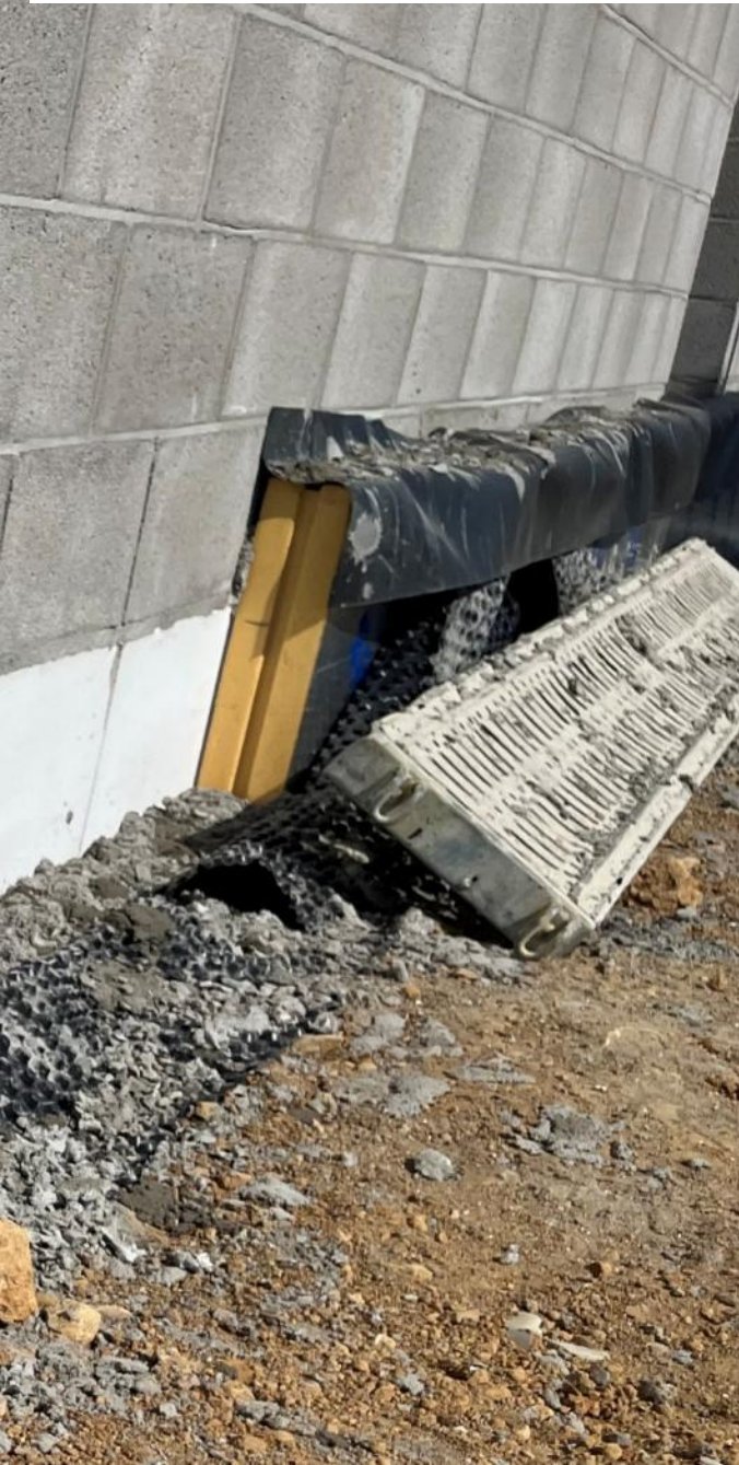
2) Isolant PIR ép. 10 cm contre le bloc béton + plinthe non isolée ép. 14 cm devant
