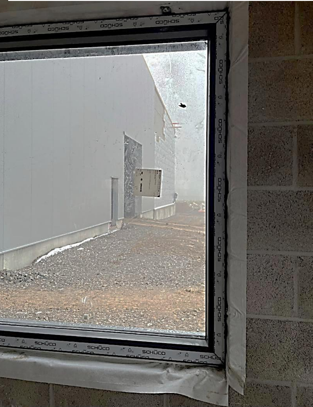
6) Membrane d'étanchéité à l'air en périphérie des châssis, collée sur la maçonnerie
