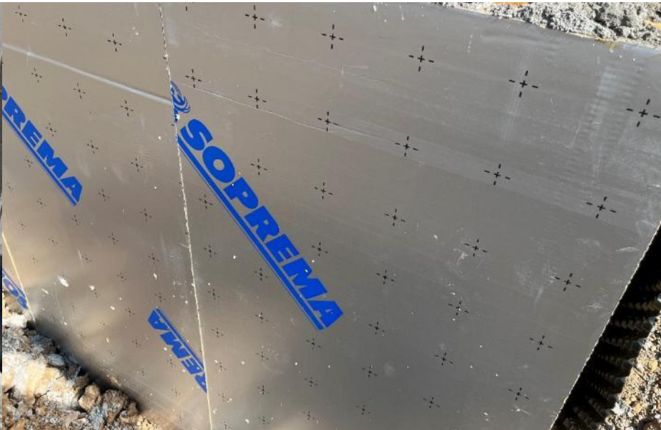
2) Isolant PIR ép. 10 cm contre le bloc béton + plinthe non isolée ép. 14 cm devant
