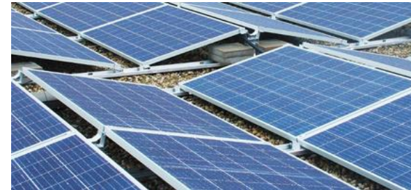
Structure en triangle, Est-Ouest
