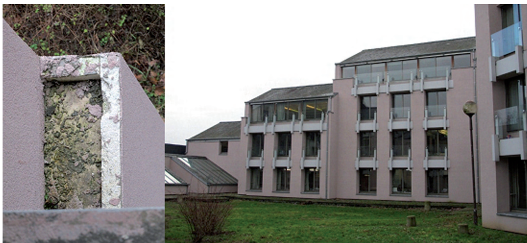
PHOTOS DU BÂTIMENT APRÈS RÉNOVATION : FAÇADE ET DÉTAIL D'ISOLATION D'UN ACROTÈRE
