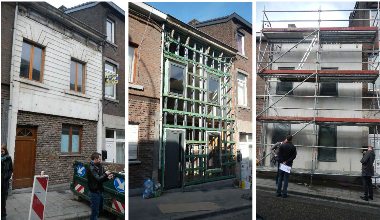
FAÇADE DU BÂTIMENT "MOLINAY 34" AVANT RÉNOVATION (À GAUCHE), PENDANT LE MONTAGE DE LA NOUVELLE FAÇADE (AU CENTRE) ET EN COURS DE FINITION (À DROITE)
