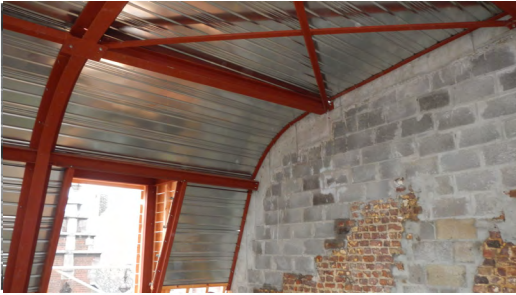
PHOTO ET MODÈLE 3D DE LA NOUVELLE TOITURE MÉTALLIQUE CINTRÉE REHAUSSANT LE DERNIER NIVEAU
