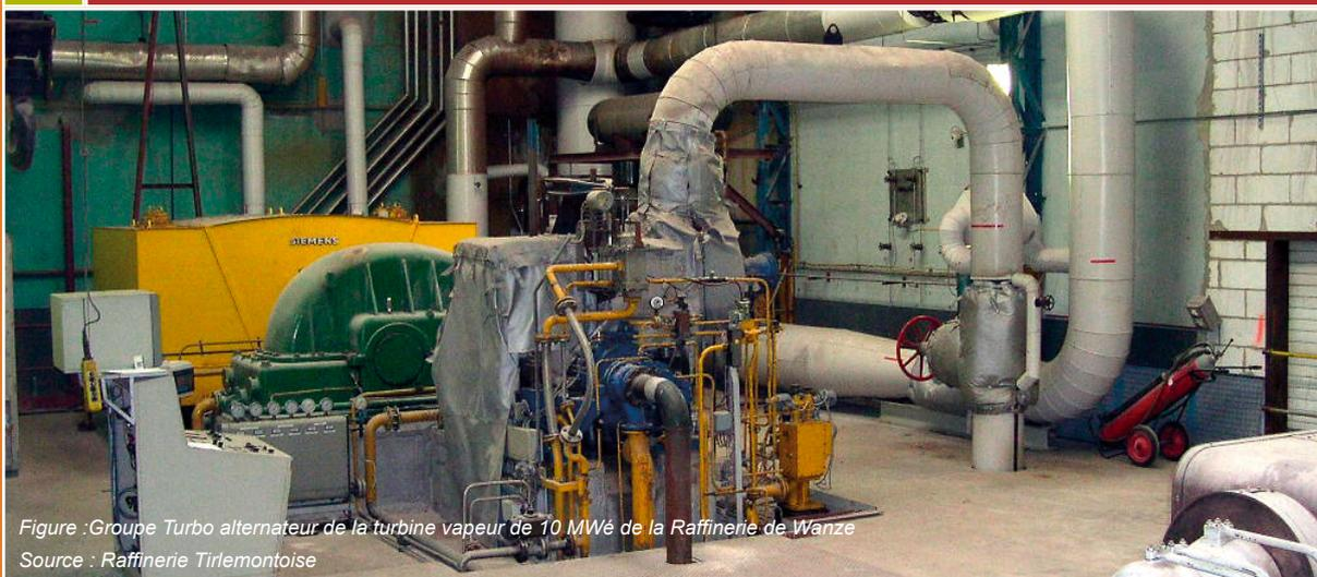
Figure : Groupe Turbo alternateur de la turbine vapeur de 10 MW<sub>e</sub> de la Raffinerie de Wanze
