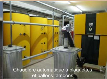
Chaudière automatique à plaquettes et ballons tampons
