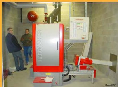
La chaudière de 100 kW avec, sur la droite, la vis de transfert des plaquettes du silo vers la chaudière
