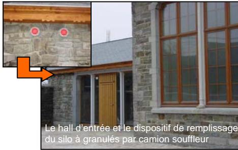
Le hall d'entrée et le dispositif de remplissage du silo à granulés par camion souffleur
