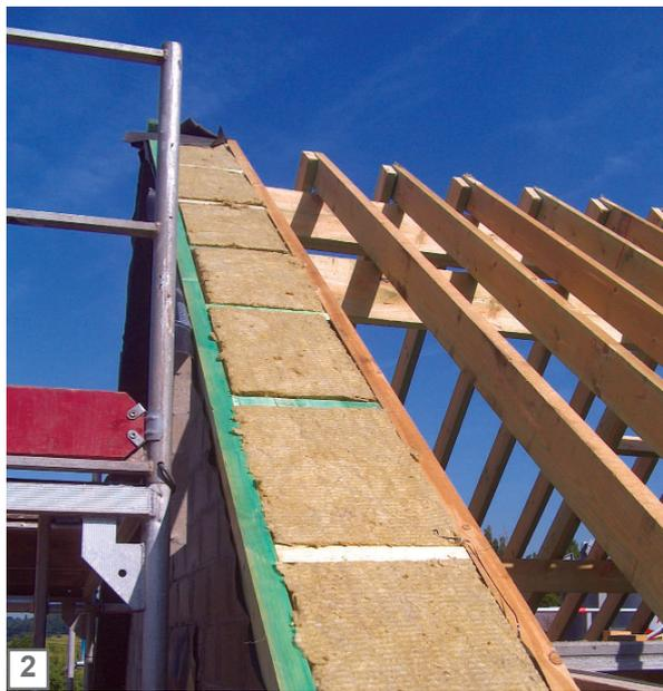
• **Photos 1 et 2** : isolation thermique au-dessus du mur porteur afin d'assurer la continuité de l'isolant entre le mur et la toiture.
