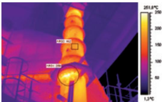
Dégradation du chemisage réfractaire d'une conduite : risques de dysfonctionnements du process, consommation augmentée pour atteindre une même température.
