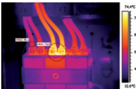
Connexion électrique défectueuse : risque d'incendie, augmentation de la résistance, donc de la consommation, perturbation du fonctionnement de l'installation et risque d'arrêt intempestif.
