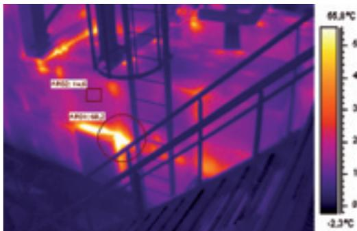
Défaut d'isolation des gaines électrofiltres de traitement de fumées avant renvoi dans l'atmosphère. Dans le cas présent, ces fumées contiennent du SO<sub>2</sub>. Le défaut de l'isolant permet la pénétration d'eau et la formation d'acide sulfurique dégradant rapidement la gaine. Conséquences : pollution perte d'efficacité.
