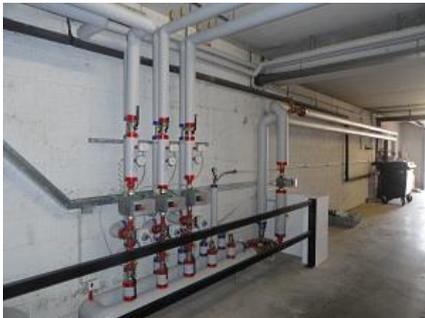
Ce fut chose faite durant 2015. L'installation a été étendue par le placement d'une boucle enterrée de chauffage vers le bâtiment administratif. Ces tuyauteries sont isolées. On peut cependant regretter que les vannes ne le soient pas.
