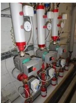
Deux autres circuits distribuent l'eau de chauffage dans deux ailes ayant des besoins thermiques différents (en fonction de leur orientation). La régulation agit aussi, en fonction de la température extérieure, sur les températures de l'eau de chauffage vers les différents circuits en fonction des besoins des utilisateurs des locaux.
