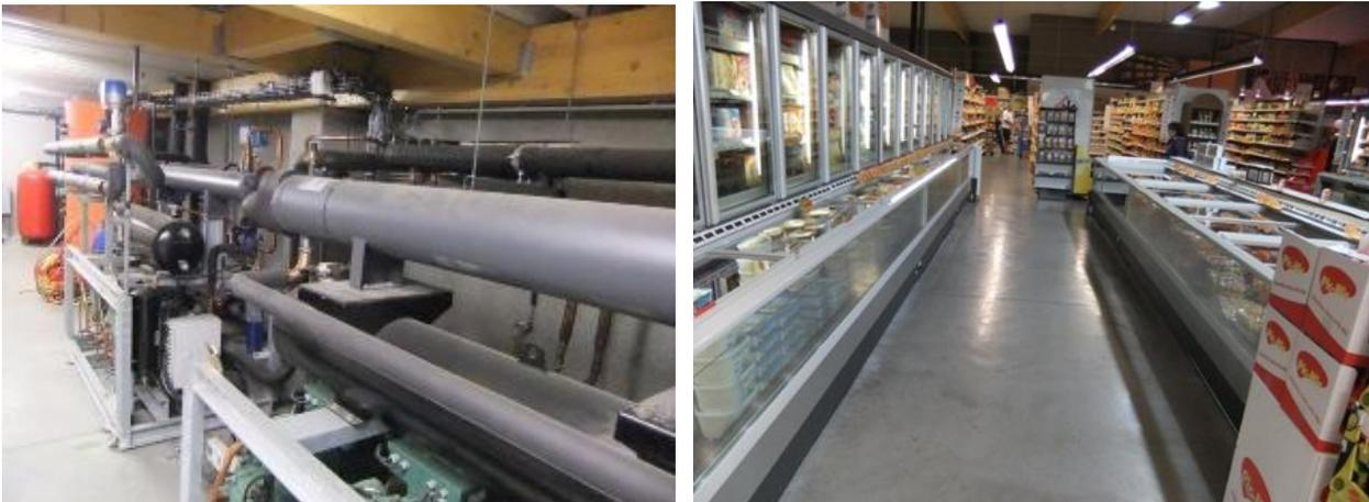
**Intermarché de Péruwelz** : récupération de calories sur groupe de froid (par échangeur et buffer d'eau chaude) pour le chauffage par le sol du magasin
