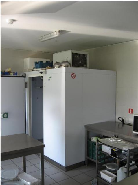
Le condenseur de la chambre froide fait partie d'un bloc de froid situé sur la chambre froide. La température ambiante au plafond peut dépasser 50°C ce qui détériore fortement le rendement de la condensation => Chambre froide bon marché à l'achat mais très énergivore !
