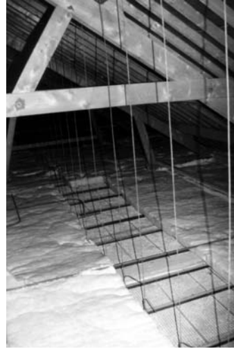
Isolation thermique des combles du bâtiment "Marchette" (chantier en cours)
