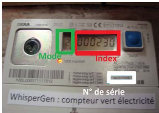
Figure 5 Exemple d'un compteur électrique vert iskra: index fonctionnel (mode 2) : 230 kW.
