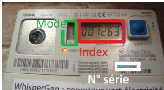
Figure 4 Exemple d'un compteur électrique vert iskra: index production (mode 7) : 1263 kW.
