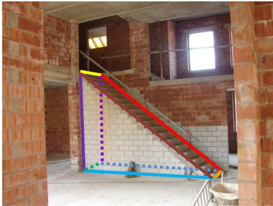
Avec la **méthode détaillée (option A)** la composition des parois influencera les pertes via le noeud constructif, l'encodage se fera alors par type d'arête avec la longueur correspondante.
