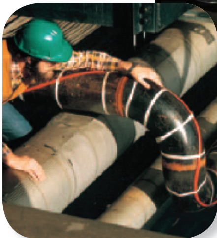
Maintien en température pour tuyauterie – Source : Tyco. Calorifugeage tuyauterie vapeur (photo de droite)
