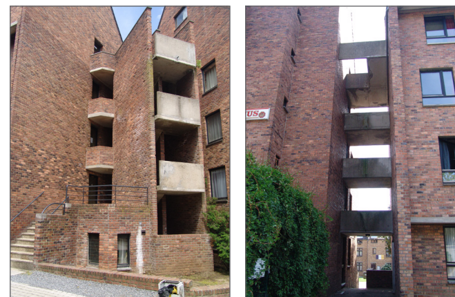
Circulations extérieures entre les bâtiments de logement étudiant existants.
