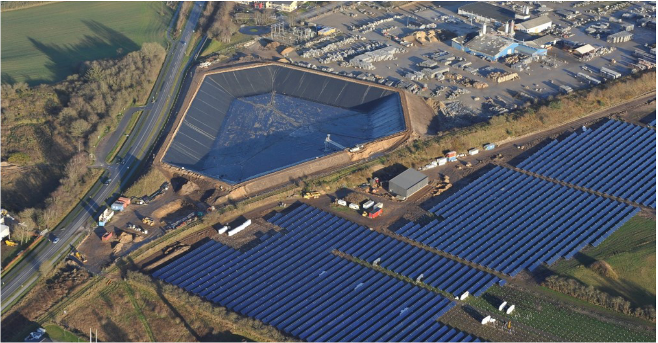
FIGURE 60 : LE RÉSEAU DE CHAUFFAGE URBAIN DE VOJENS EST ÉQUIPÉ D'UN SYSTÈME CENTRAL DE STOCKAGE THERMIQUE SENSIBLE (PTES) QUI EST CHARGÉ GRÂCE À UN CHAMP DE CAPTEURS SOLAIRES PENDANT L'ÉTÉ.
