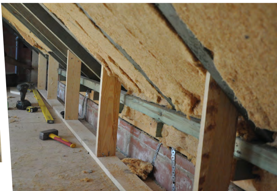
Vissage en oblique de part et d'autre du montant
