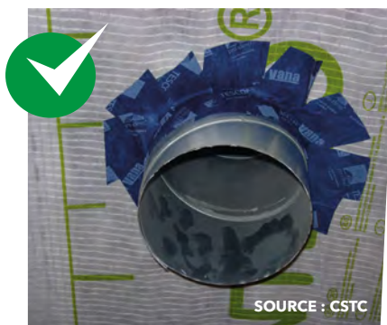
Pose radiale des bandes adhésives (solution satisfaisante)
