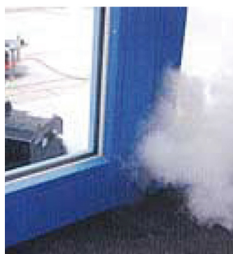
Test de fumée, source AIE 37
