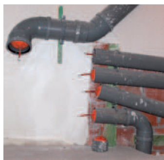
Zone non plafonnée derrière des tuyauteries, Source CSTC
