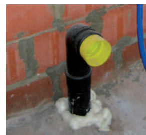
Raccord en mousse de polyuréthane autour d'un percement d'une décharge à travers une dalle monolithe, Source CSTC
