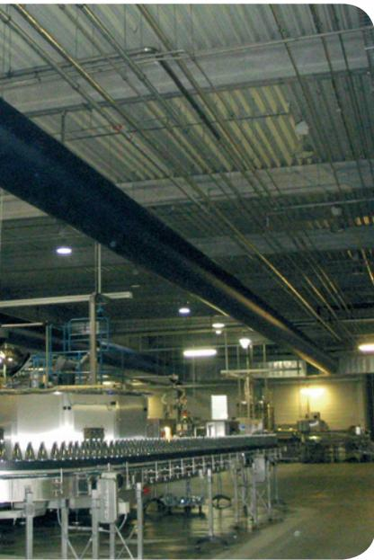
Zone d'embouteillage avec les gaines de soufflage. Source : SPA
