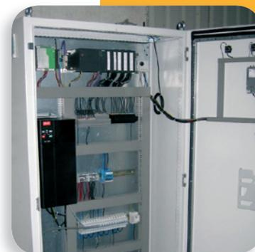
Régulation ECS et monitoring stockage thermique. Source : Coretec Engineering
