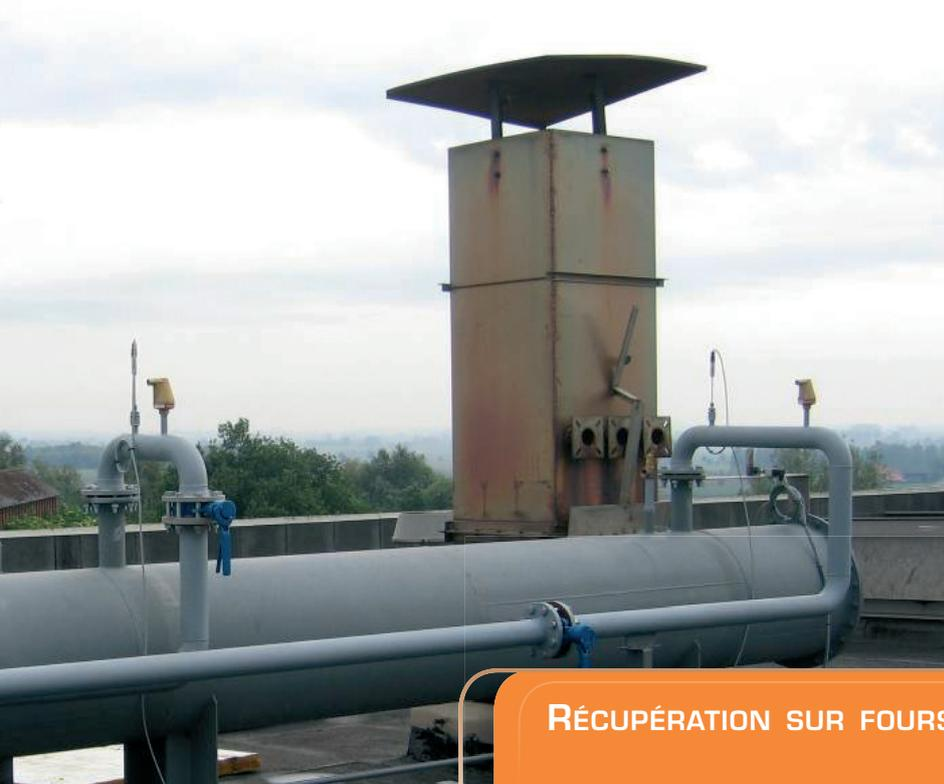
Abattoir : cheminée du four à flamber avec échangeur de récupération. Source : Coretec Engineering.
