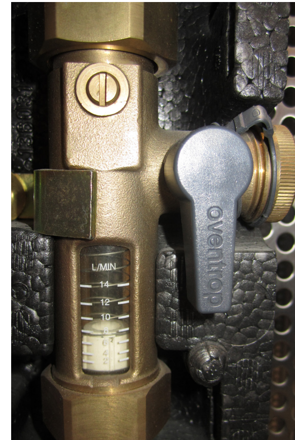
Fig. 17 a. Le débitmètre gravimétrique
