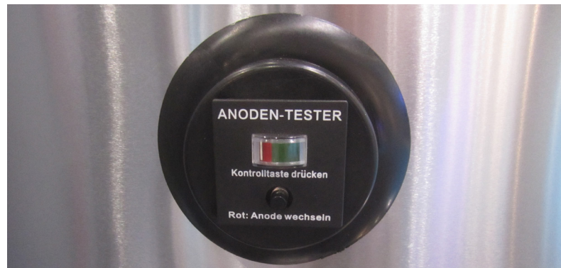
Fig. 30. Le témoin de test de l'anode en magnésium
