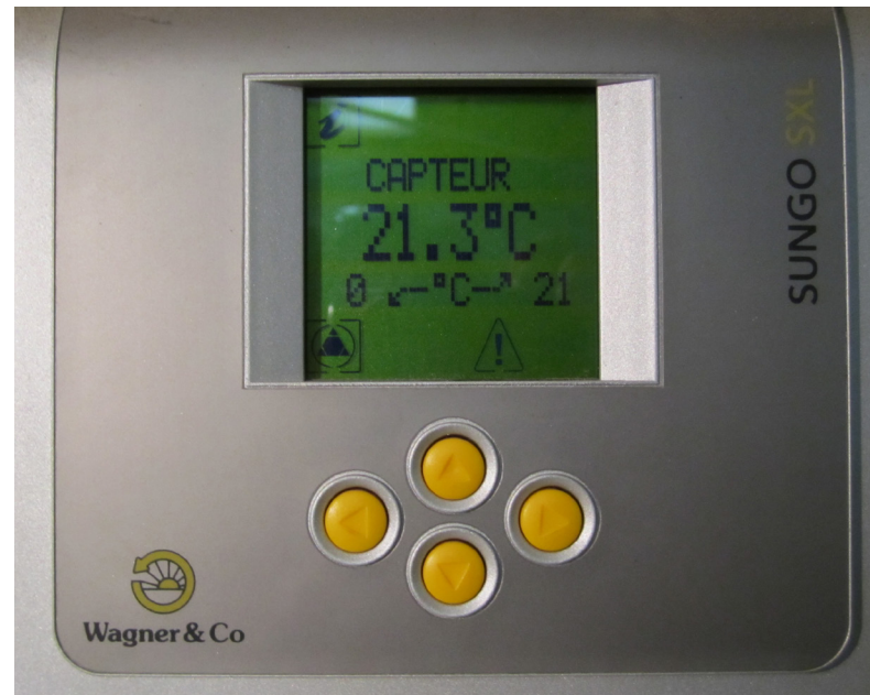
Fig. 14 b. La régulation solaire électronique
