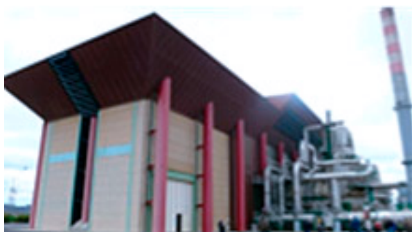
Figure 2: Centrale géothermique de Valle Secolo (Toscane, Italie)
