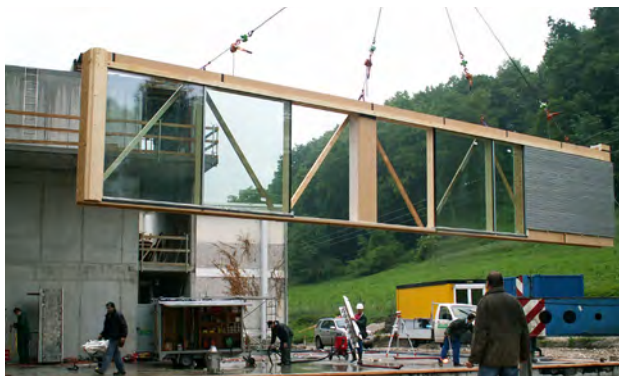
Rénovation d'une école dans la ville de Schwanenstadt, in Autriche. Objectif: augmenter la compacité et l'isolation grâce à des façades préfabriquées. Source: www.HAUSderZukunft.at , Images © PAUAT Architekten and Günter Lang
