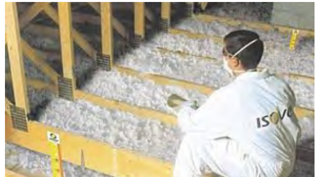
Mise en oeuvre de flocons de laine de verre - © Isover
