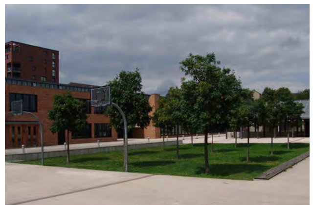
Ecole à Scharnhäuserpark - Allemagne- Image: V. Mahaut
