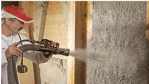
Mise en oeuvre de la cellulose - © Thermofloc
