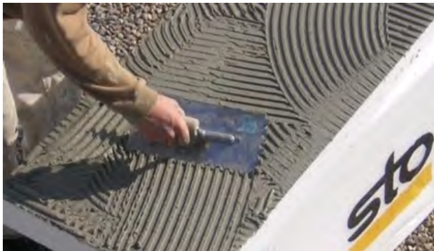
Mise en oeuvre d'un isolant EPS - © Sto
