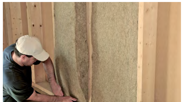
Placement de la laine de bois- © Biofib
