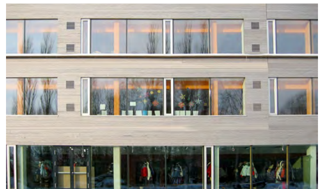
Rénovation d'une école dans la ville de Schwanenstadt, in Autriche. Objectif: augmenter la compacité et l'isolation grâce à des façades préfabriquées. Source: www.HAUSderZukunft.at , Images © PAUAT Architekten and Günter Lang
