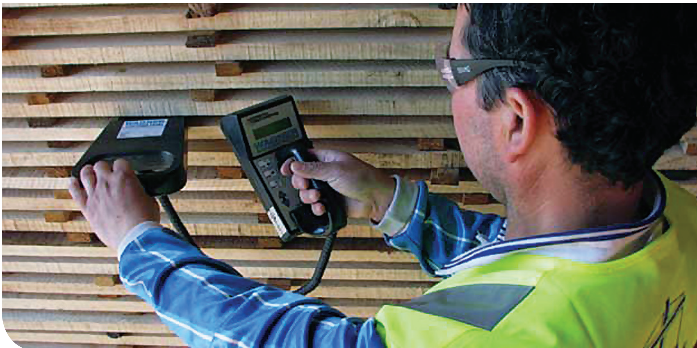
Sondage d'humidité. Source : tpcristo
