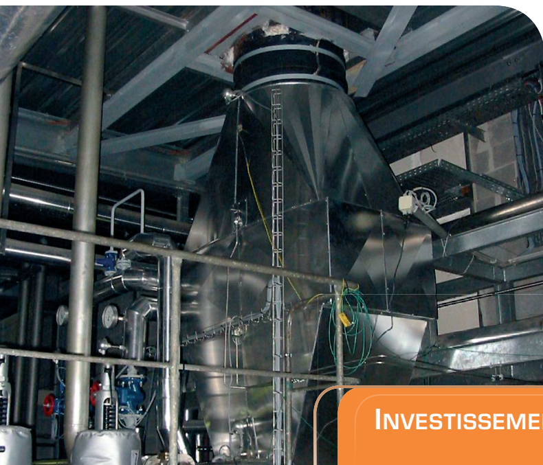
Installation d'un économiseur sur une chaudière existante
