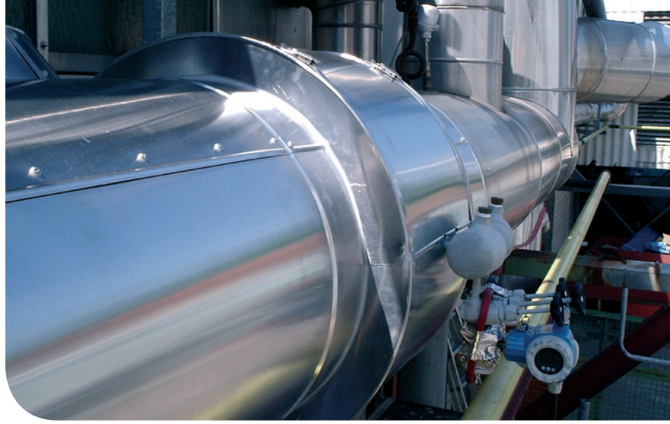
Débitmètre vapeur de type delta p. Source : Endress&Hauser
