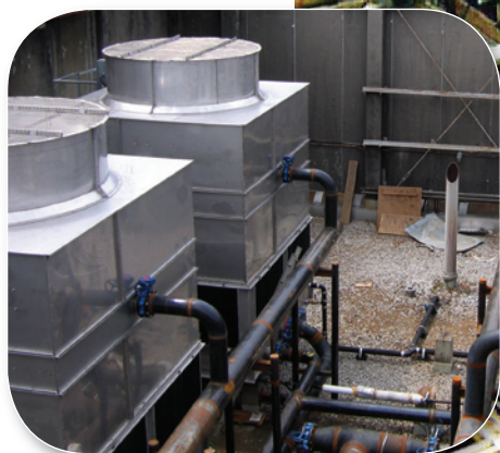
Tours de refroidissement. Sources : WGI, AstraZeneca.
